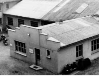
Viessmann Firmengebäude in Allendorf, Ende der 40er Jahre
